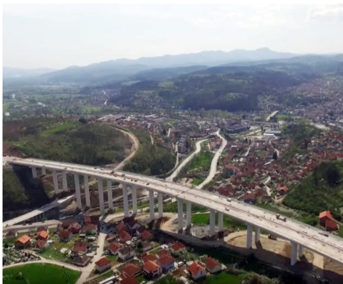
Хидрозолација на мост Врла – Коридор 10, Владички Хан, Србија
