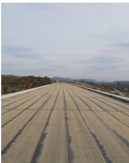
Хидрозолација на мостови на Експресен пат Штип – Радовиш, Македонија - STRABAG
