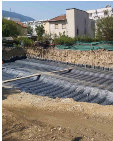
Подземна хидроизолација и хидроизолација на партер на станбено - деловен објект " Garden INN Residence", Скопје, Македонија – BIS OIL
