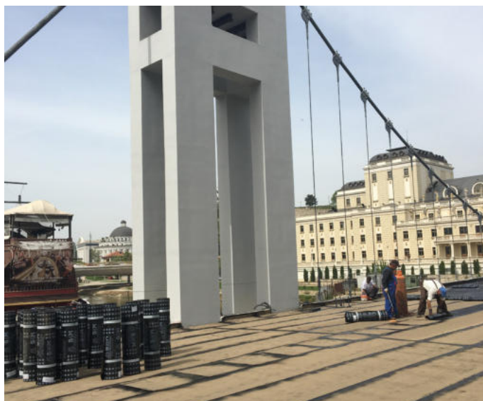
Хидрозолација на пешачки мост на Вардар, Скопје, Македонија – ДГ БЕТОН АД Скопје
