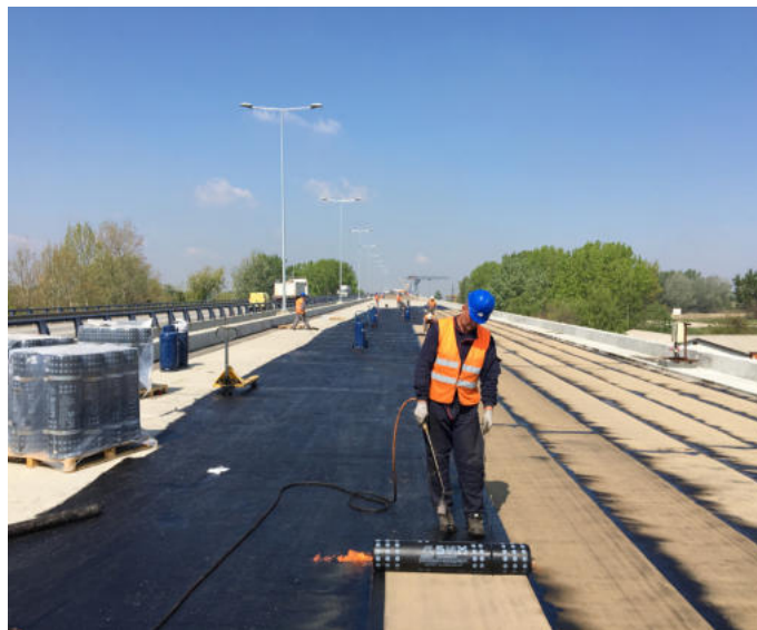
Хидрозолација на мост на обиколница Остружница, Белград , Србија - STRABAG
