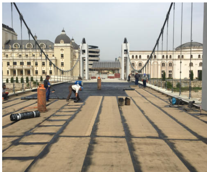
Хидрозолација на пешачки мост на Вардар, Скопје, Македонија – ДГ БЕТОН АД Скопје
