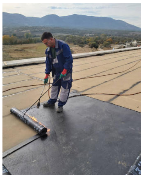
Хидрозолација на мостови на Експресен пат Штип – Радовиш, Македонија - STRABAG
