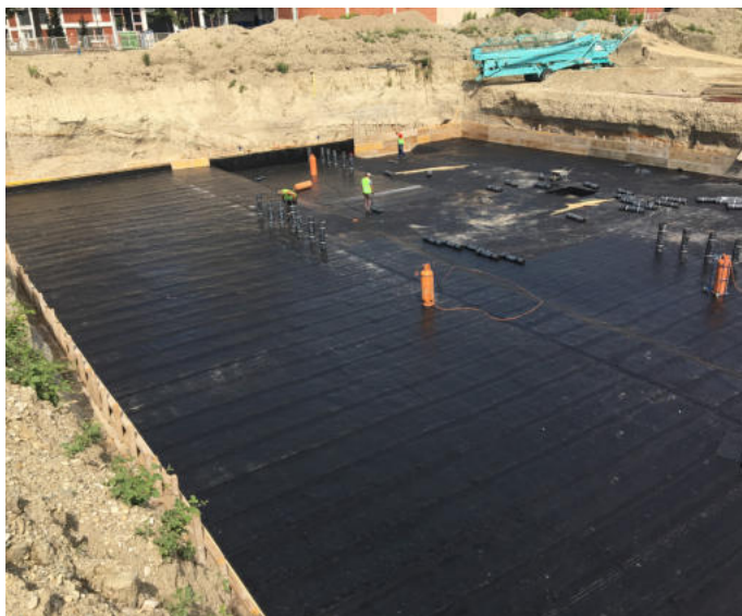
Подземна хидроизолација и хидроизолација на партер на станбено - деловен објект " Garden INN Residence", Скопје, Македонија – BIS OIL
