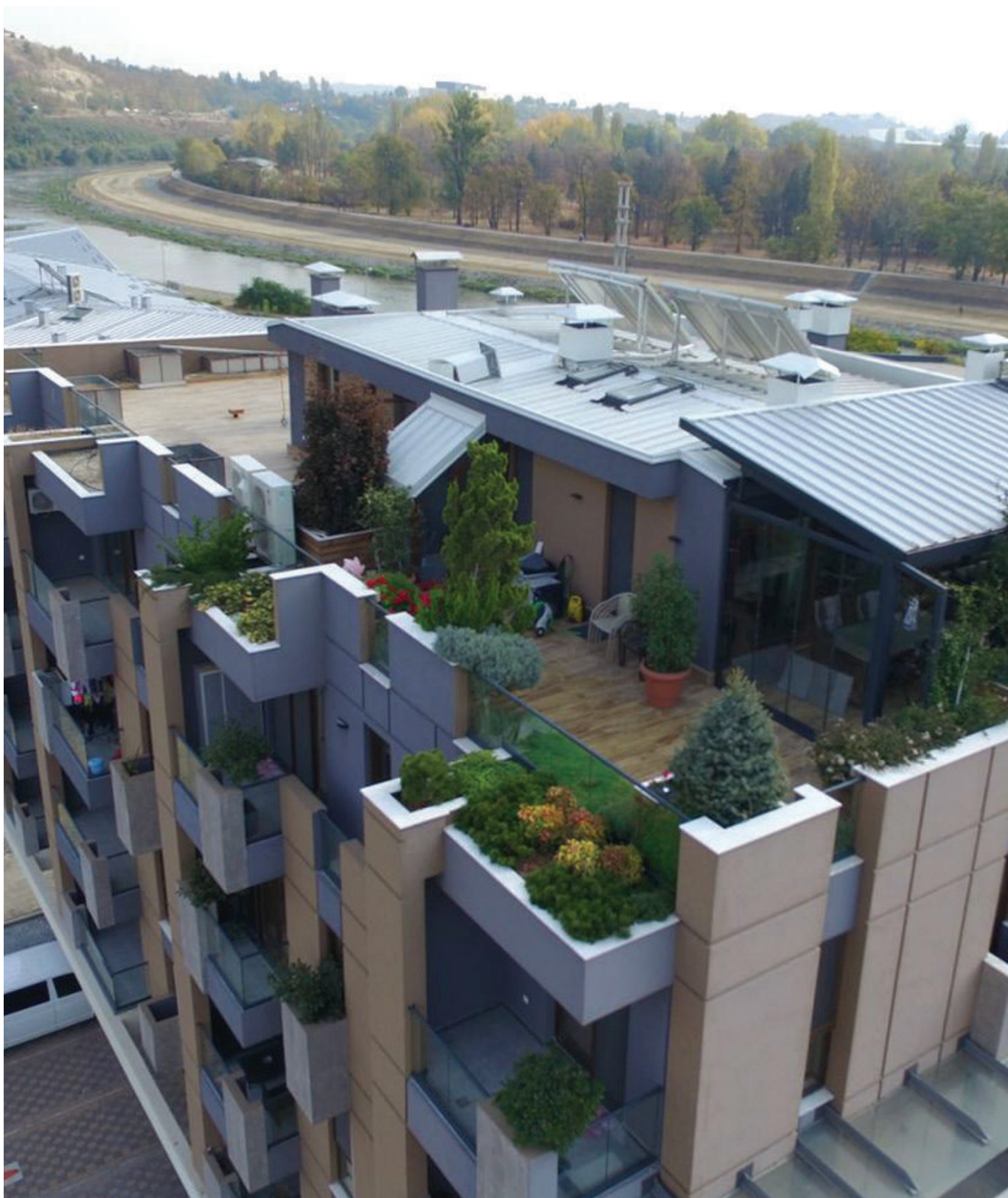
Хидроизолација на зелен кров - станбен објект во Криви Дол , Хрисинг ФС ДООЕЛ
