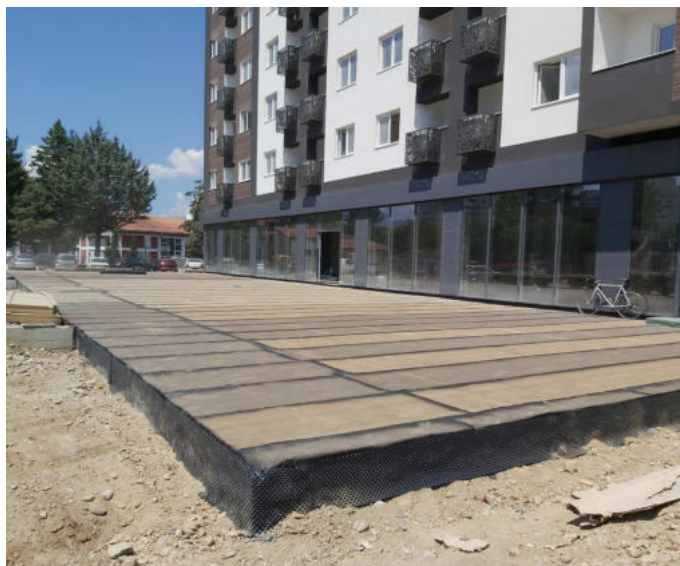
Подземна хидроизолација и хидроизолација на партер на станбено - деловен објект " Garden INN Residence", Скопје, Македонија – BIS OIL
